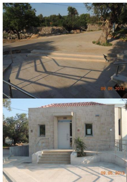
Slika 4. Pogled (gore) s rampe na kolni pristup i (dolje) pročelje postojećeg objekta recepcije Izvor: http://www.eding.hr/vise/recepcija-vrtovi-lunjskih-maslina-34.html
