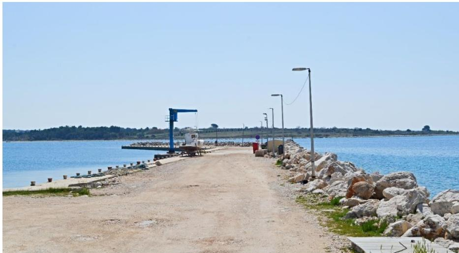
**Slika 2.7.** Pogled na sjeverni lukobran sa obalnim zidom na unutarnjoj strani i dizalicom te zaštitnim kamenometom na vanjskoj strani
