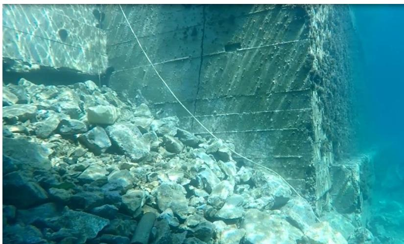
**Slika 2.11.** Betonski obalni zid platoa dizalice s vidljivom vertikalnom pukotinom
